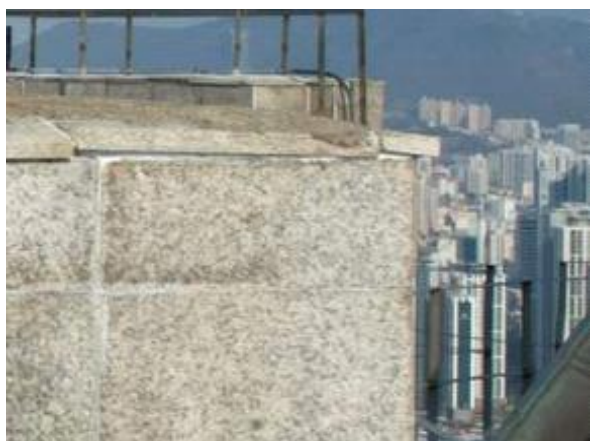
그림 87. 2023년 수리 전 탑신부 석재마감 들뜸(좌), 석재마감 파손(우)(출처: 부산시설공단)
