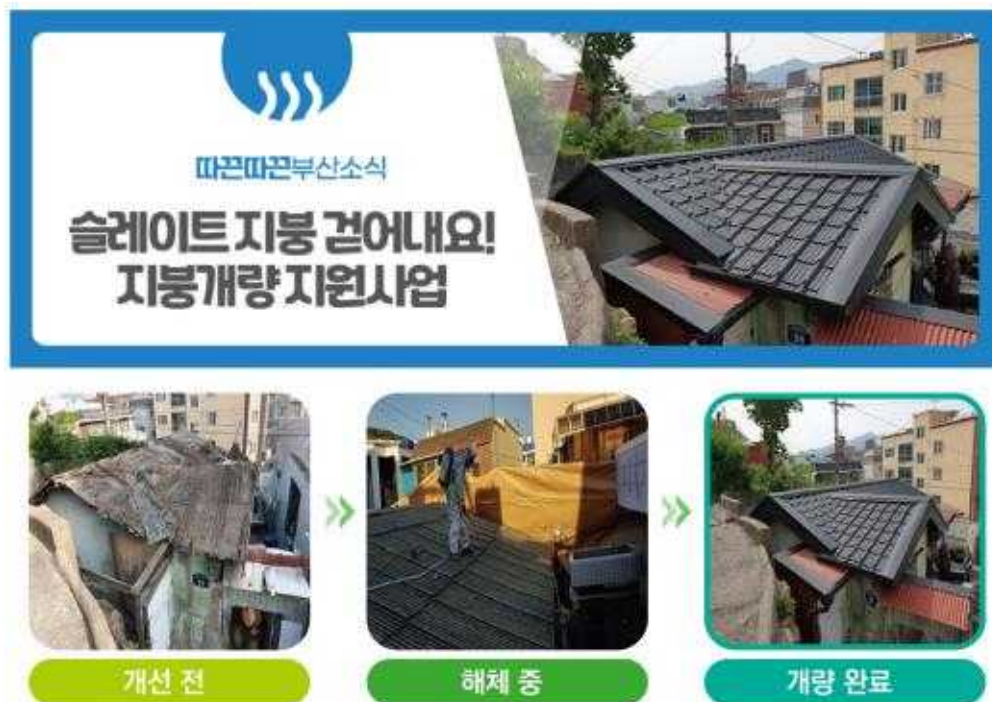
[그림 VI-25] 슬레이트 철거 및 지붕개량 사업 예시
